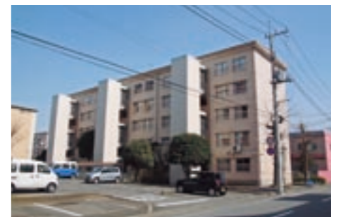
市営住宅のエレベータ設置
