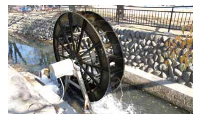
佐久間川に設置した小水力発電装置。昔の水車を思い出す人も多いことでしょう。発電した電気は児童文化センターや前橋子ども公園で利用しています
