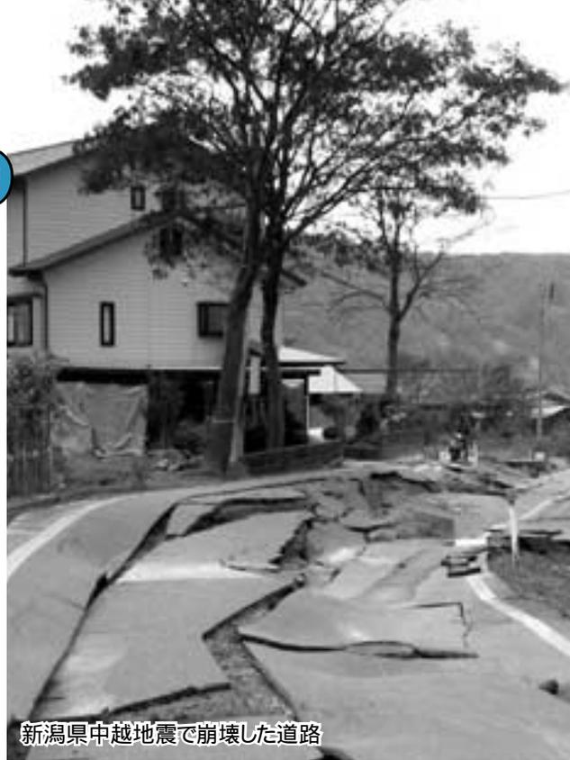
新潟県中越地震で崩壊した道路
