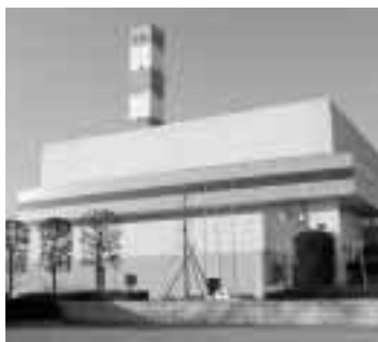
環境に配慮(六供清掃工場)
