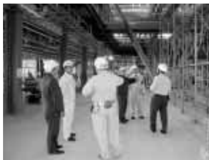
工事現場をパトロール
