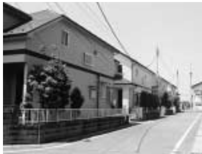
住宅などの建築状況を調査
