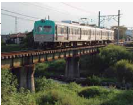
変わらぬ姿を残す荒砥川橋梁
