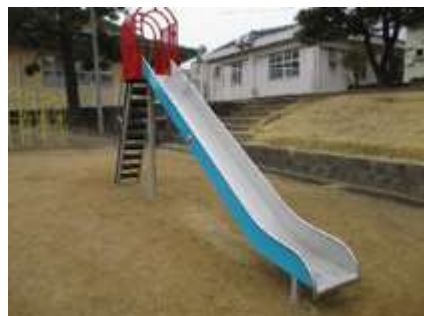
すべり台新設
