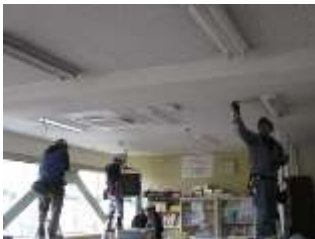
照明のLED化工事
