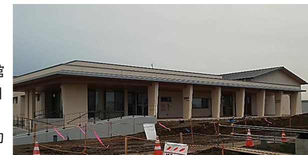
新築工事中の永明分館
