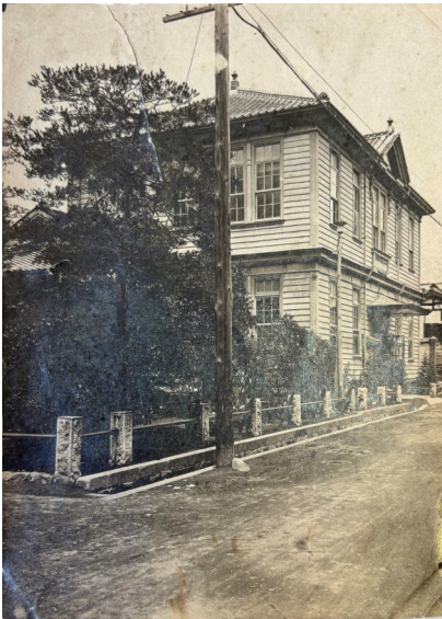
前橋市立図書館初代館舎
