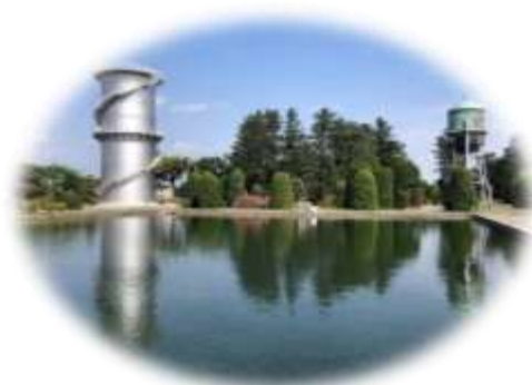
『写真：敷島浄水場』
