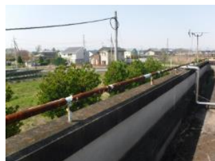
手すりの腐食
