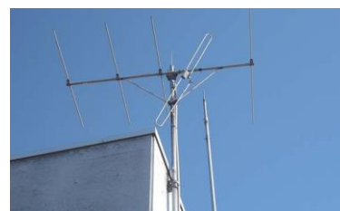
設備機器の落下の危険性
