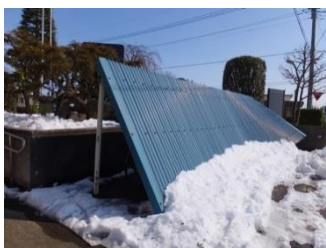
積雪による倒壊
