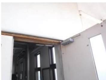
ドアクローザーの破損
