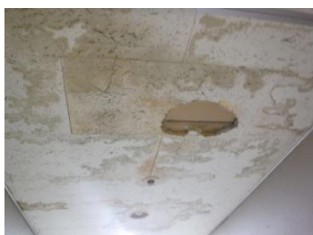
雨漏りのシミ・天井材の破損
