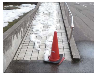
スロープの滑り
