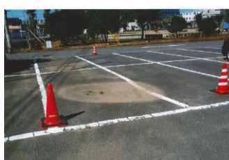
舗装の陥没
