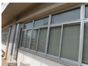
窓のガタツキ
