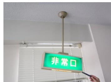
天井取付部の確認
