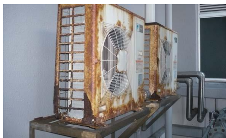
室外機の腐食
