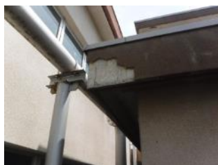
モルタルの落下
