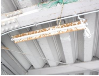
照明器具の損傷
