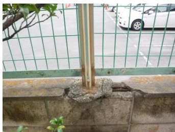
支柱部分の腐食
