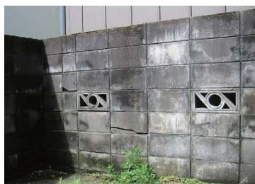
ブロック塀のひび
