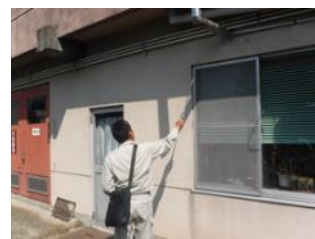
モルタルの浮き
