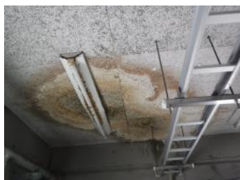
照明器具の腐食
