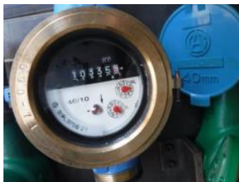
漏水の確認(水道メーター)
