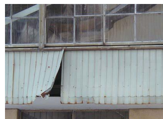
金属板のはがれ
