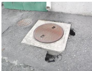
排水柵周りの陥没
