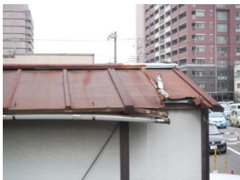
金属屋根の飛散
