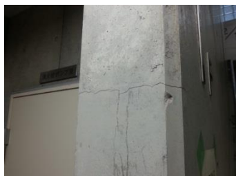
コンクリート柱のクラック
