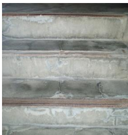
滑り止めの欠損
