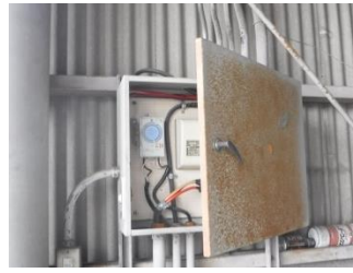
分電盤の開閉確認
