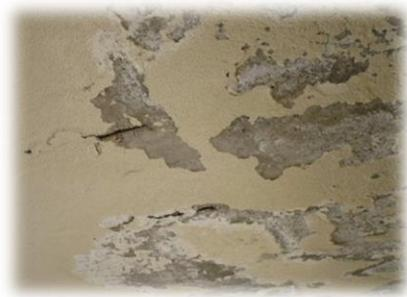
モルタル塗り外壁の剥落
