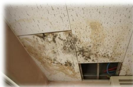
雨漏りによる天井のシミ・カビの剥離
