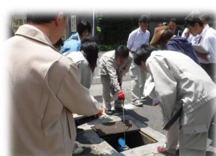
水道メーターによる漏水の点検
