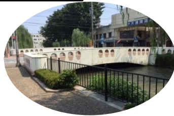
道路・橋りょう
