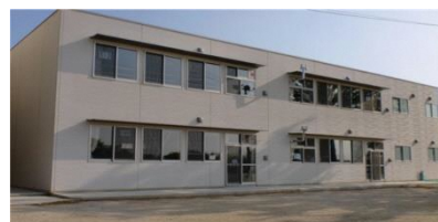
南校舎増築 工事完了
