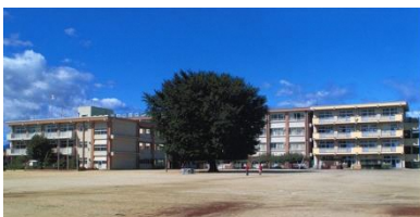
校舎大規模 改造工事完了
