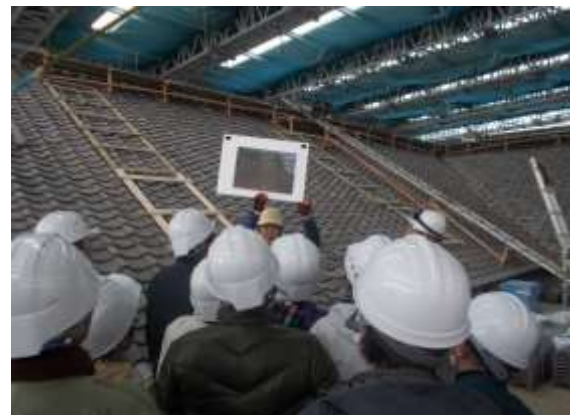
大屋根の瓦葺き替え工事の説明を！
