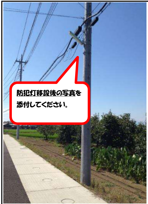
○撤去前の専用柱写真
