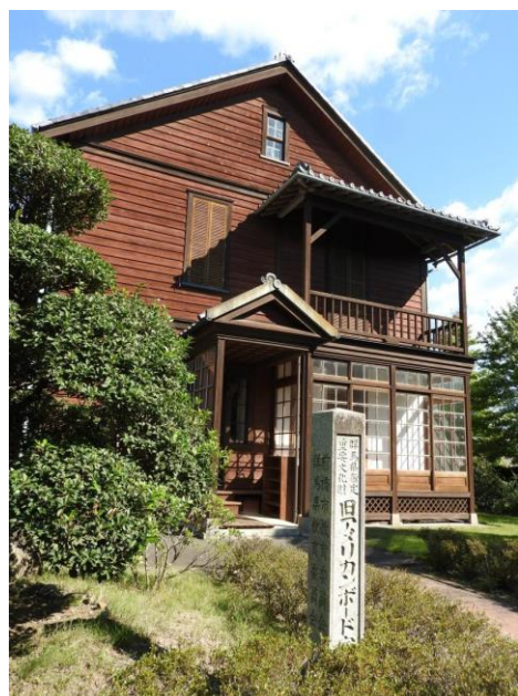
玄関やバルコニーを切妻側に備える西洋建築の特徴を持つ
