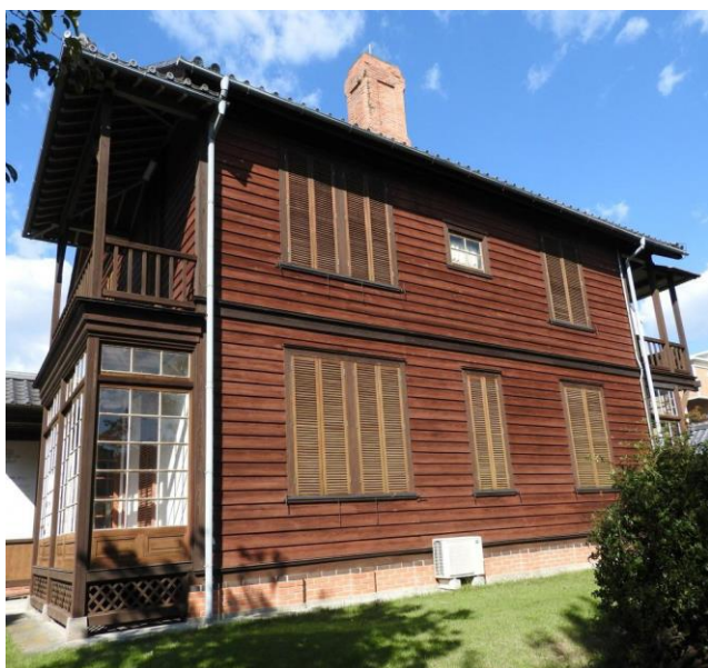
旧宣教師館は二階建て、外壁は横板張り、両開き縦長窓などが西洋建築の特徴を良く表している
