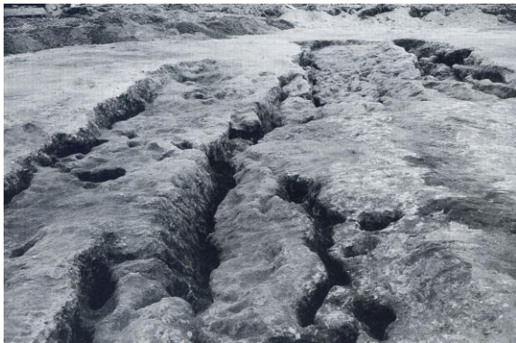
平成元年－笠懸町の清水西丘遺跡の大規模な地割れ。
