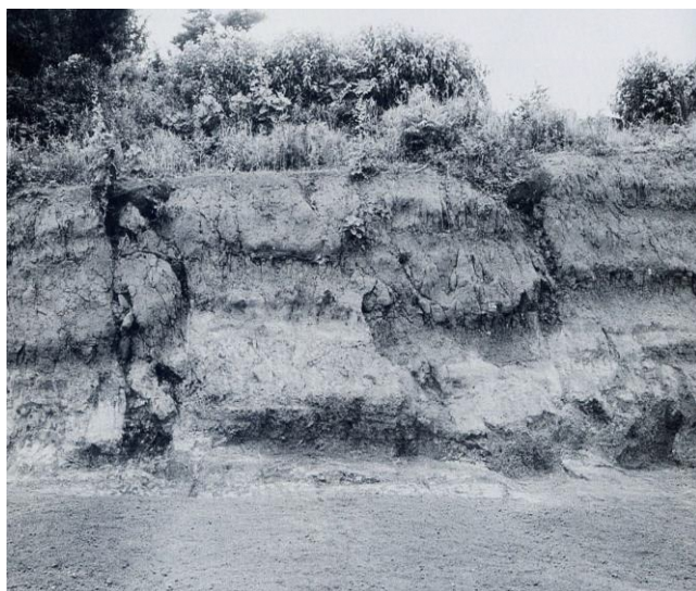
奥沢の大日遺跡で発見された陥没断層。
