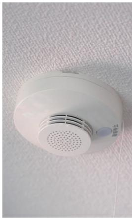
住宅用火災警報器の設置義務化から10年以上が経過。電池切れや故障での動作不良が問題となっており、電池の寿命は約10年。定期的に作動点検をしてください。点検は警報器本体のボタンを押すか、ひもを引きます。音声が届かない場合は交換してください。消防局では住宅用火災警報器の取り付けを支援しています。詳しくは問い合わせください。
