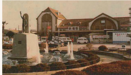
JR 前橋駅周辺の歴史的景観を高めます。先代前橋駅舎の一部再現や、かつて駅前広場にあった噴水の復元などが想定されます。
