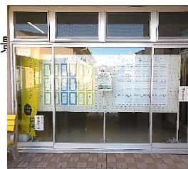
【元総社中学校】 (ホール廊下窓の南側)
