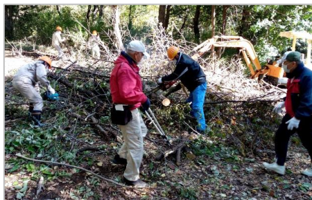
危険木撤去作業の様子（11月10日）
