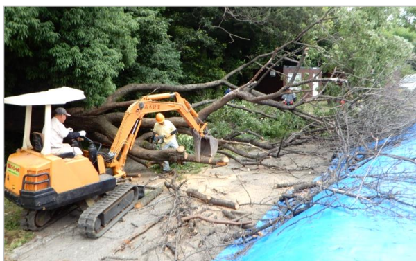
危険木撤去作業の様子(6月18日)
