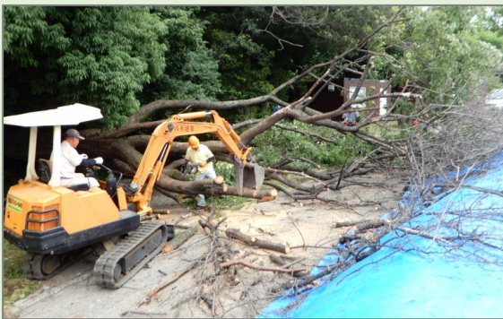
危険木伐倒・撤去作業（6月18日）
