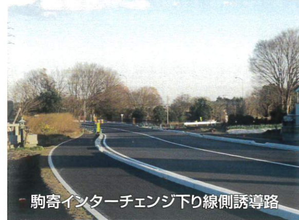
駒寄インターチェンジ下り線側誘導路
