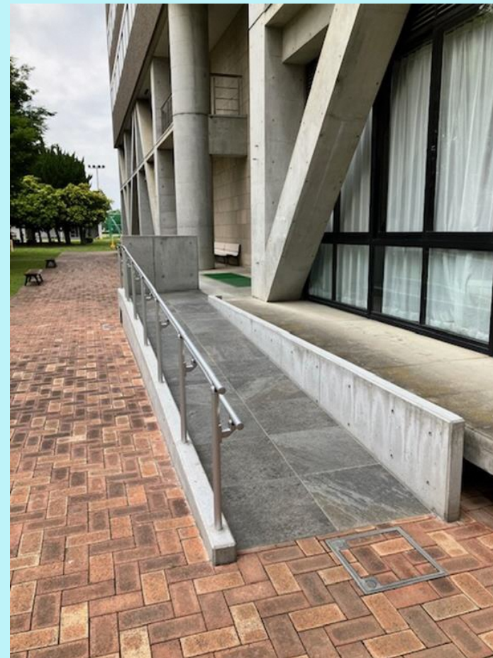
《 4号館南出入口の外側へのスロープ設置工事 》
