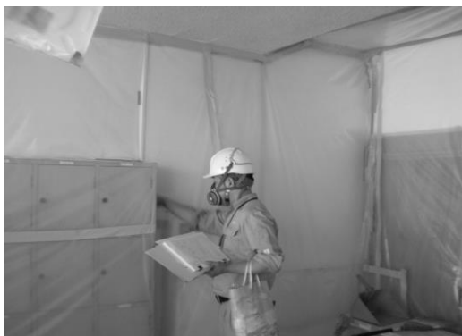
写真「立入調査の様子」
