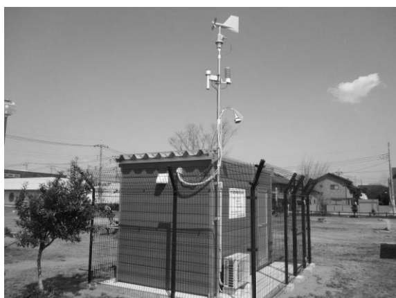
写真「大気汚染常時監視局（前橋南局）」
