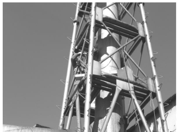
写真「気体排出口でのサンプリング」
