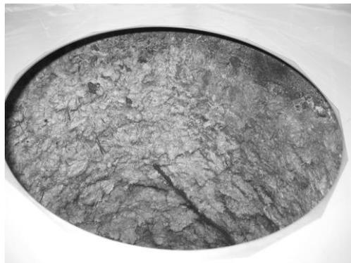
写真「煙突内の石綿断熱材」
