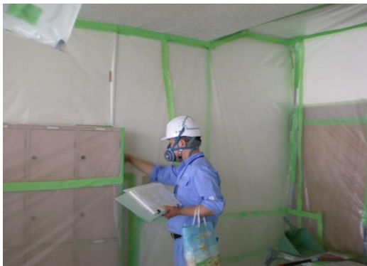
写真「立入調査の様子」
