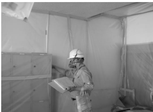
写真「立入調査の様子」
