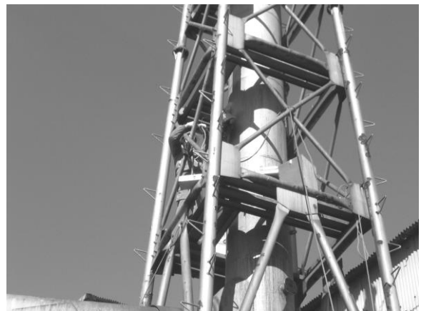
写真「気体排出口でのサンプリング」
