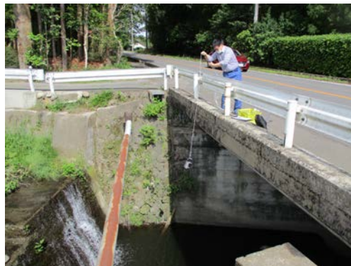
河川調査（大穴川）
