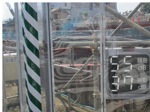
工事現場の騒音振動測定器
