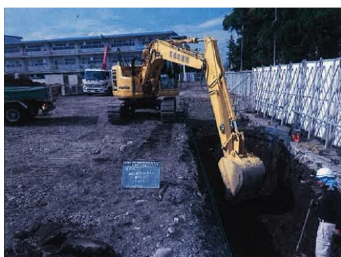
土壌掘削調査
