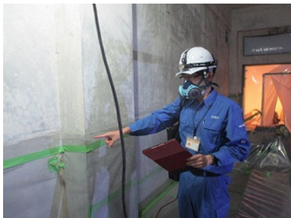
特定粉じん排出作業立入調査
