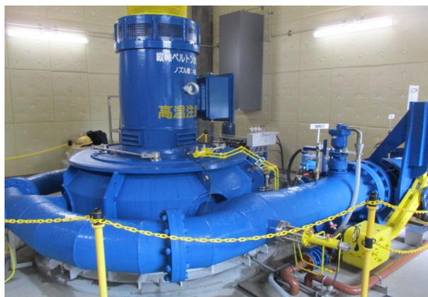
小水力発電所内にある『立軸ペルトン水車発電機』
