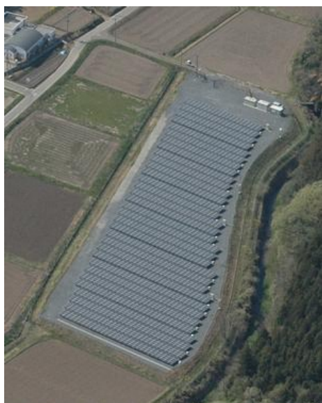
まえばし堀越町太陽光発電所
