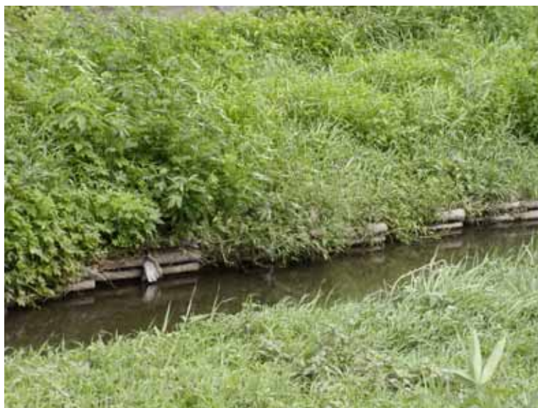
写真：赤城白川（細井新橋）周辺の木杭工護岸（撮影：平成16年8月）
