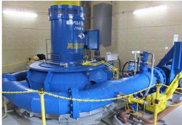
写真「小水力発電所内にある『立軸ペルトン水車発電機』」
