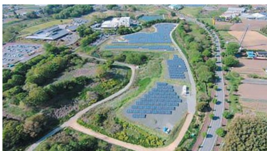
まえばし荻窪町太陽光発電所
