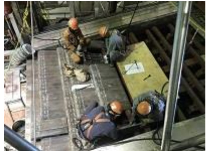
ハイパー火格子据付(燃烧壇)
