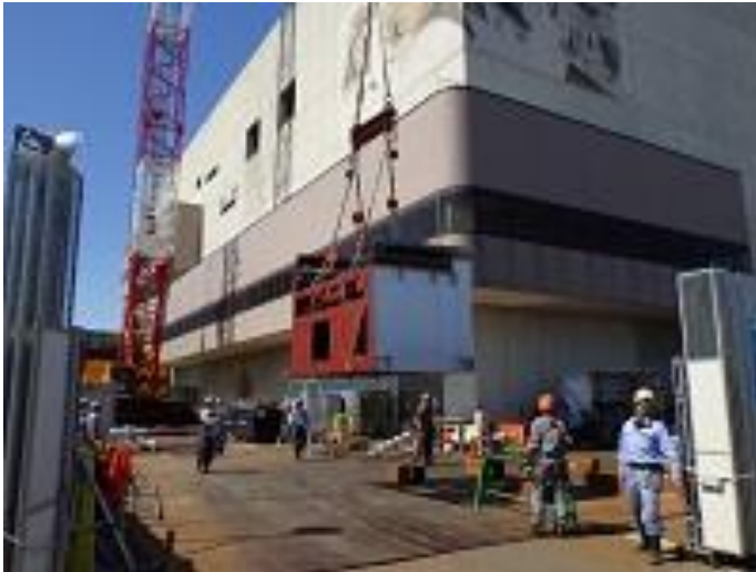
燃烧装置(後燃烧段)を2分割にて吊上げ
