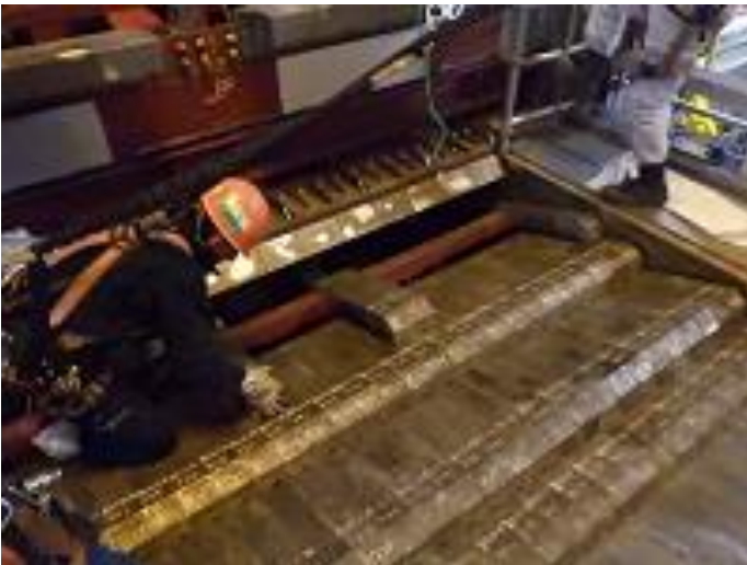
ハイパー火格子据付作業(後燃烧段)
