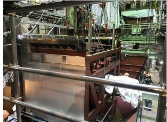
燃烧装置据付作業(後燃烧段)
