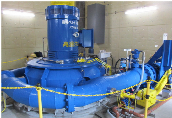
『立軸ペルトン水車発電機』
