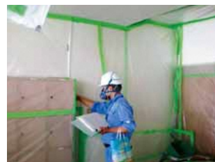
立入調査の様子
