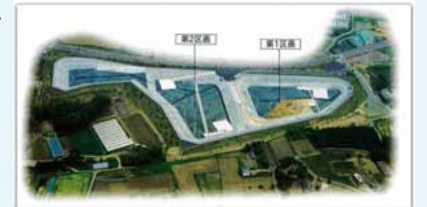
前橋市最終処分場
