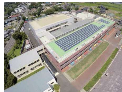
市有施設への太陽光発電の設置 （大胡東小学校）
