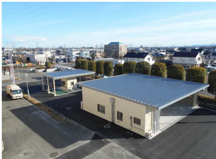
外観（西側より）
