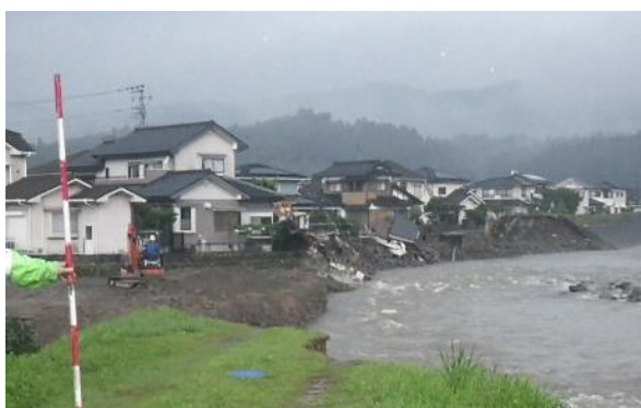
河岸侵食による家屋の倒壊(花月川)
