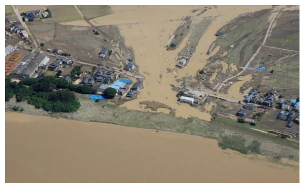
堤防決壊による家屋の流失(鬼怒川)
