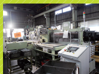
牧機械製作所 工場内部
