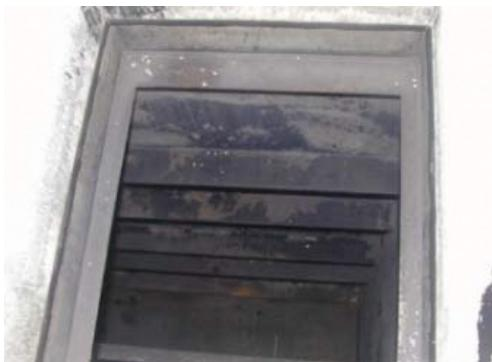
腐食抑制剤を使用している缶体
