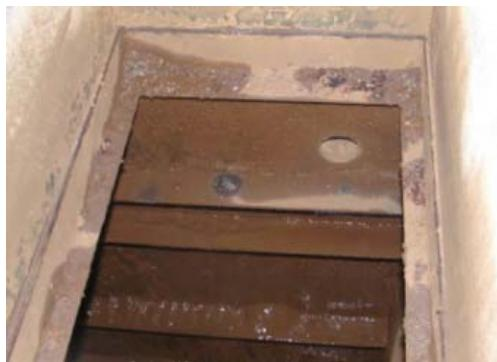
腐食抑制剤を使用していない缶体
