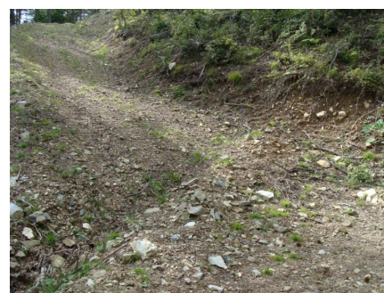
素掘りによる横断溝
